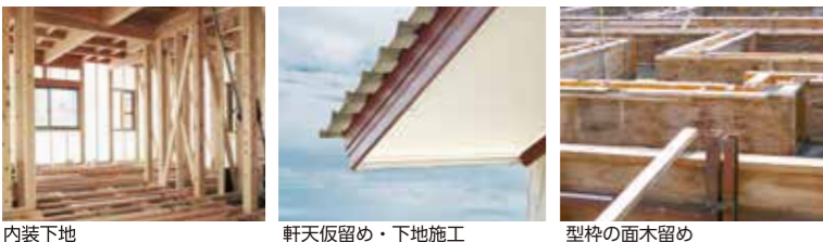
内装下地 軒天仮留め・下地施工 型枠の面木留め
